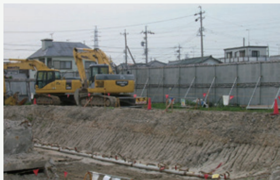
大型重機 騒音対策
