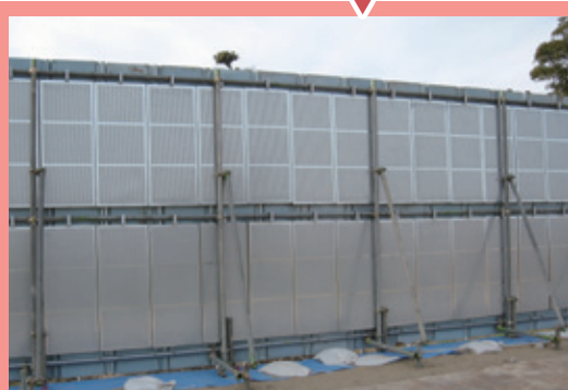
防音壁の完成
