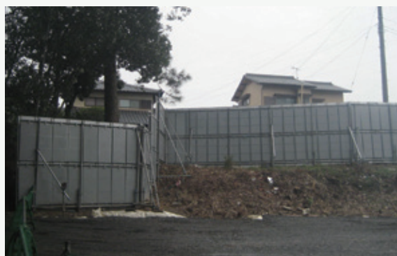
鉄骨工事 騒音対策
